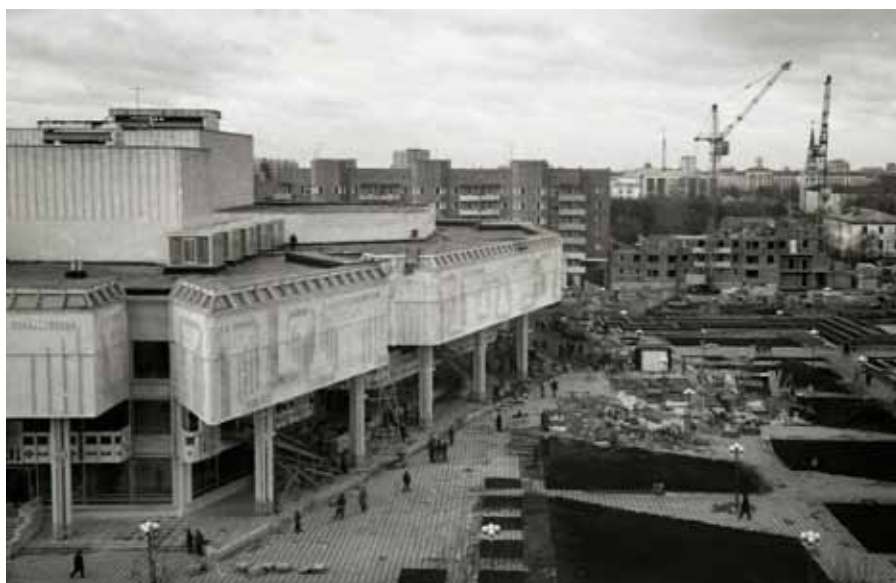
Идет строительство ТЮЗа.
